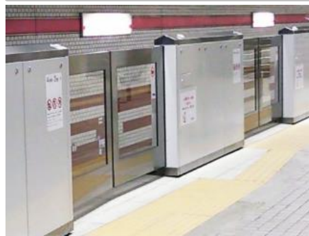
可動式ホーム柵／車両床面の隙間解消
