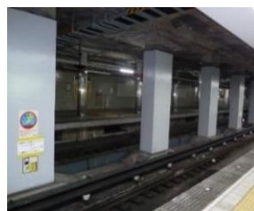
トンネル中柱補強
