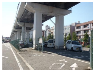
高架橋の橋脚補強
