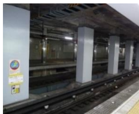
トンネル中柱補強
