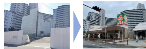
使用しなくなった地下鉄変電所に生活利便施設を誘致
