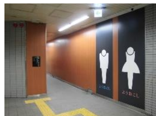
トイレ(リニューアル後)
