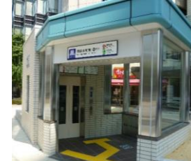
エレベーター増設
