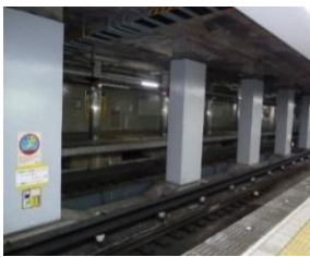
トンネル中柱補強
