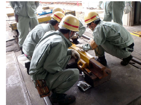
応急処置器の取り付け
