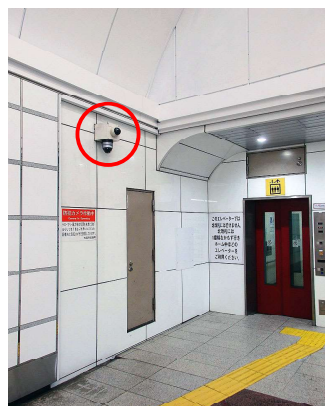
防犯カメラ設置例
