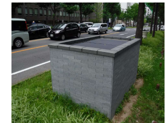
線路が地下から地上に移行する区間などの対策イメージ
