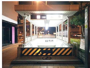
止水パネル設置例
