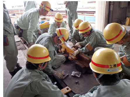
応急処置器の取り付け
