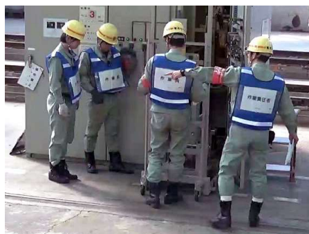
配電盤での感電
