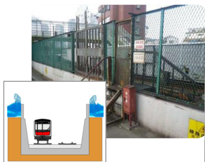
側壁のかさ上げ
