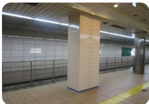
耐震補強工事
