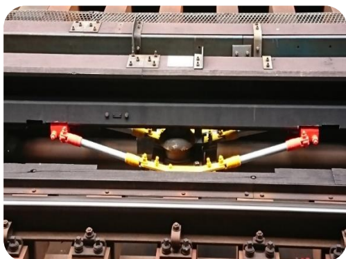
サードレール脱落防止
