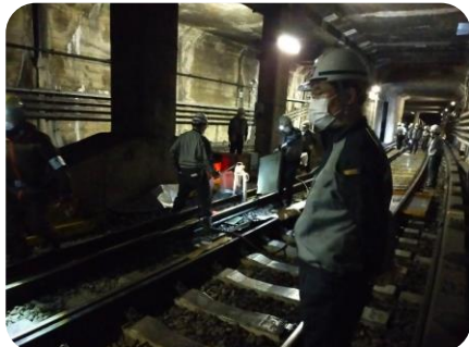
線路（レール）交換夜間作業
