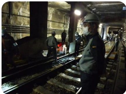
線路（レール）交換夜間作業
