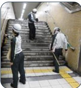
建築技術者は、建築仕上げ材の不具合を速やかに確認・把握するため、目視や打音による定期的な点検を実施しています。建築施設の状態から処置が必要と判断した部位について、応急措置や大規模修繕工事の計画・実施を行っています。また、駅構内での火災等を想定し、速やかに避難していただけるよう設置している防火シャッターなど防災設備の点検・整備を行っています。これら建築施設の予防保全に努め、安全で快適な施設の提供に取り組んでいます。
