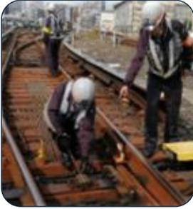
電気技術者は、電車の安全・安定輸送を確保するとともに、お客さまに快適にご利用いただくため、電気設備の保守を日夜実施しています。各種設備は電気指令所で24時間集中監視するとともに、設備故障時には、保守区社員が現場に駆け付け、故障箇所を特定し、部品交換や修繕を行っています。また、日々の点検では五感を働かせ設備の異常や変化の発見に努め、障害発生前に処置を施し、安全・快適にご利用いただくため尽力しています。
