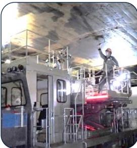
保線技術者は、日々の巡視検査において軌道状態を確認し、電車走行時の「音」を聴き分け、目視や詳細調査をもとに損傷状態を把握し、必要な対策を講じています。また、構築物を担当する技術者は、コンクリート片の剥落一つが重大事故に直結する恐れがあることから、事後保全だけでなく、事前に劣化を抑制する予防保全に力を入れて、構築物の延命化、輸送の安全確保に取り組んでいます。
