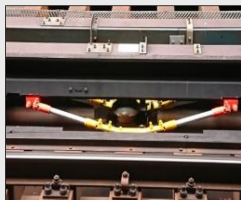
高架部サードレール脱落防止 (2019年度で全て設置完了)
