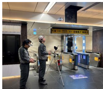
駅天井内施設点検状況
