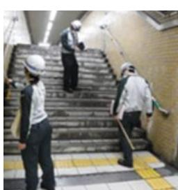
建築技術者は、建築仕上げ材の不具合を速やかに確認・把握するため、目視や打音による定期的な点検を実施しています。建築施設の状態から処置が必要と判断した部位について、応急措置や大規模修繕工事の計画・実施を行っています。また、駅構内での火災等を想定し、速やかに避難していただけるよう設置している防火シャッターなど防災設備の点検・整備を行っています。これら建築施設の予防保全に努め、安全で快適な施設の提供に取り組んでいます。
