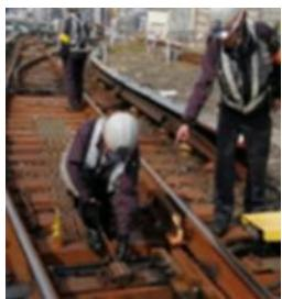
電気技術者は、電車の安全・安定輸送を確保するとともに、お客さまに快適にご利用いただくため、電気設備の保守を日夜実施しています。各種設備は電気指令所で 24 時間集中監視するとともに、設備故障時には、保守区社員が現場に駆け付け、故障箇所を特定し、部品交換や修繕を行っています。また、日々の点検では五感を働かせ設備の異常や変化の発見に努め、障害発生前に処置を施し、安全・快適にご利用いただくため尽力しています。
