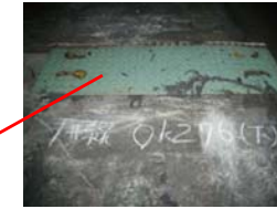
溝ふたを設置
