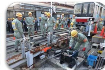
損傷したポイント据え付け用品を交換状況
