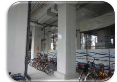
朝潮橋駅 橋脚補強工事
