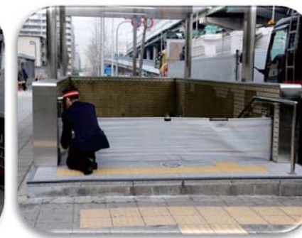
止水シートの設置状況 (中央線 谷町四丁目駅)
