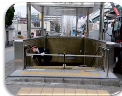
止水シートの設置状況 (中央線 谷町四丁目駅)
