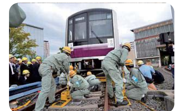
脱線復旧状況
