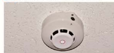
8 煙感知器(自動火災報知設備)
