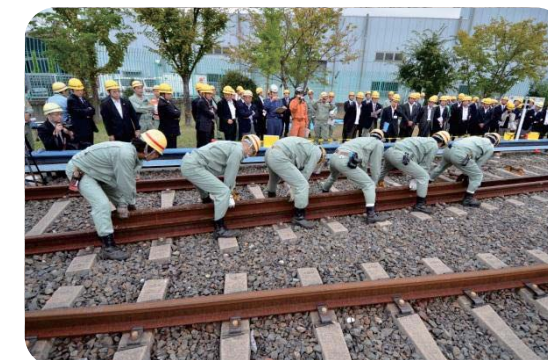
レール交換作業状況
