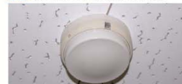
9 熱感知器(自動火災報知設備)
