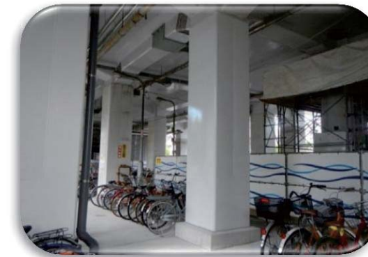
朝潮橋駅 橋脚補強工事
