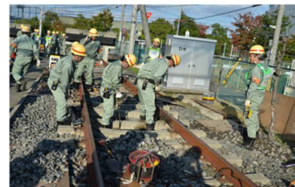
損傷したまくらぎの交換状況
