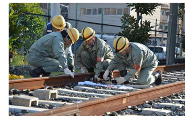
損傷した信号ケーブルの交換状況
