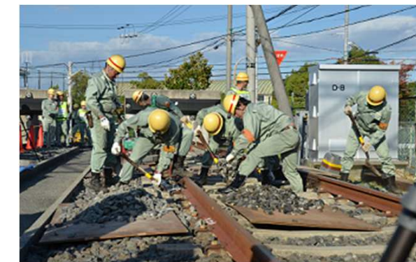
損傷したまくらぎの交換状況 （道床碎石掘削状況）
