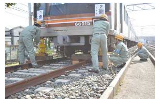
脱線した車両復旧のためのジャッキの設置
