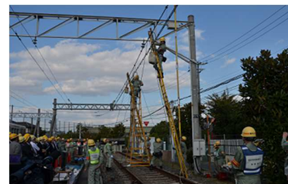
損傷した架線の補修状況
