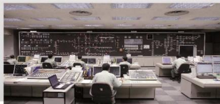
電気指令所では、多種多様な電気設備をトータルに管理している。列車の運転や駅の照明などに必要な電力の供給をコントロールするとともに列車の運行や営業に必要な電気設備を24時間監視し、故障等の迅速な対応を行い、列車運行の信頼性の向上を図っている。
