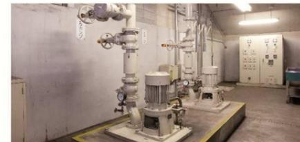
地下鉄内で発生する水は、施工継目等からの漏水する地下水と、駅構内で使用する洗浄水等であり、この水を線路部や駅の貯水槽に集め、排水設備(揚水ポンプ)で下水道に排水している。
