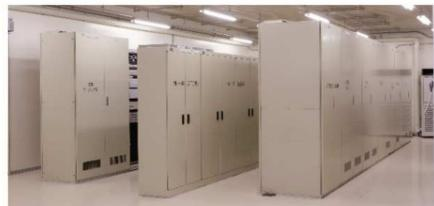
地下鉄の正確な列車運行と輸送の安全を確保するため、連動装置や自動列車制御装置(ATC)等の信号設備がある。
