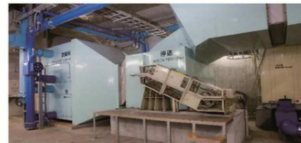
真夏のラッシュ時には、機械による換気だけでは車両や駅設備からの発生熱量の抑制ができなくなり、冷凍機や空調機により駅構内の冷房を行っている。
