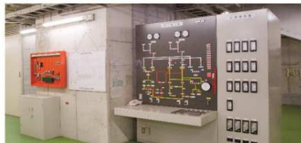
電気室は、変電所から受電した電源を高圧遮断機から変圧器・低圧遮断機・電磁接触器等を経て、電灯用設備などに配電している。
