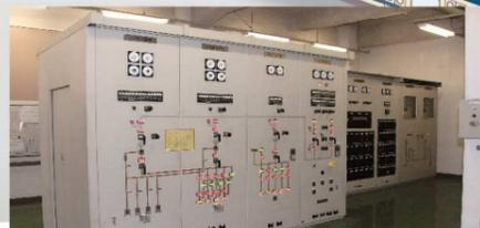
変電所は、地下鉄に必要な電力を関西電力から特別高圧(3相交流22kV)を常用と予備2回線を受電し、駅や列車に供給している。
