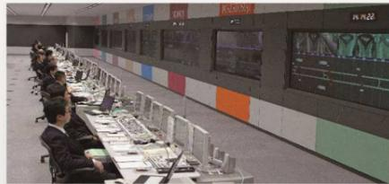
輸送指令所には、全列車の運行状況がひと目でわかる列車集中表示盤、各駅の信号やポイントを1箇所ですべて制御する集中制御盤、列車無線及び駅ホーム等を映し出すCCTVシステムを備え、全列車の運行を集中管理している。
