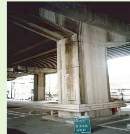
橋脚補強工事
