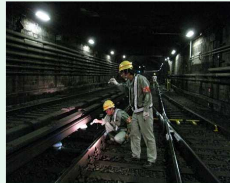
サードレールの点検
