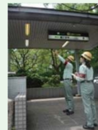
各所仕上げ材の 目視点検
