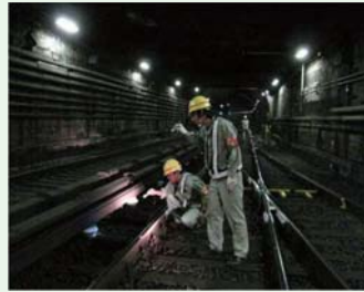
サードレールの点検
