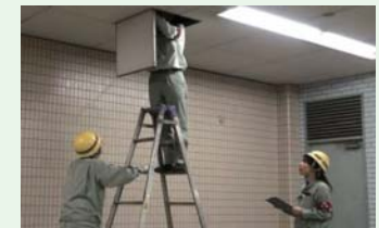
コンコース天井内の設備機器点検
