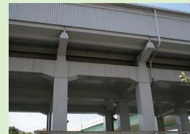
落橋防止工事
