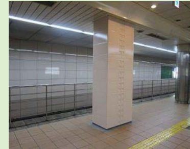
橋脚補強工事
