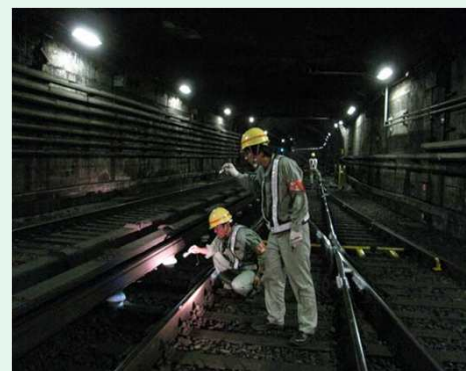
サードレールの点検
