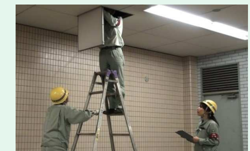
コンコース天井内の設備機器点検
