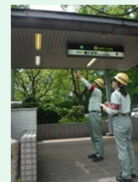
各所仕上げ材の 目視点検
