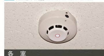
8 煙感知器(自動火災報知設備)
