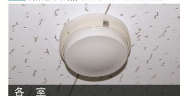
9 熱感知器(自動火災報知設備)
