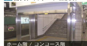
14 防火シャッター(二段落とし)
