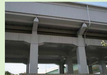
落橋防止工事
