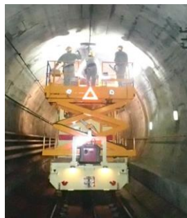
構造物の点検
