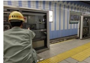
可動式ホーム柵の整備
