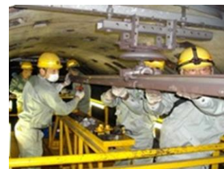
電車線の整備
