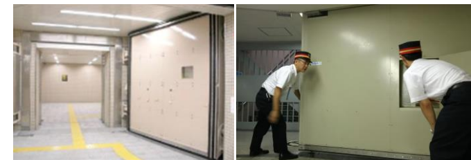
止水扉と扉の設置訓練
